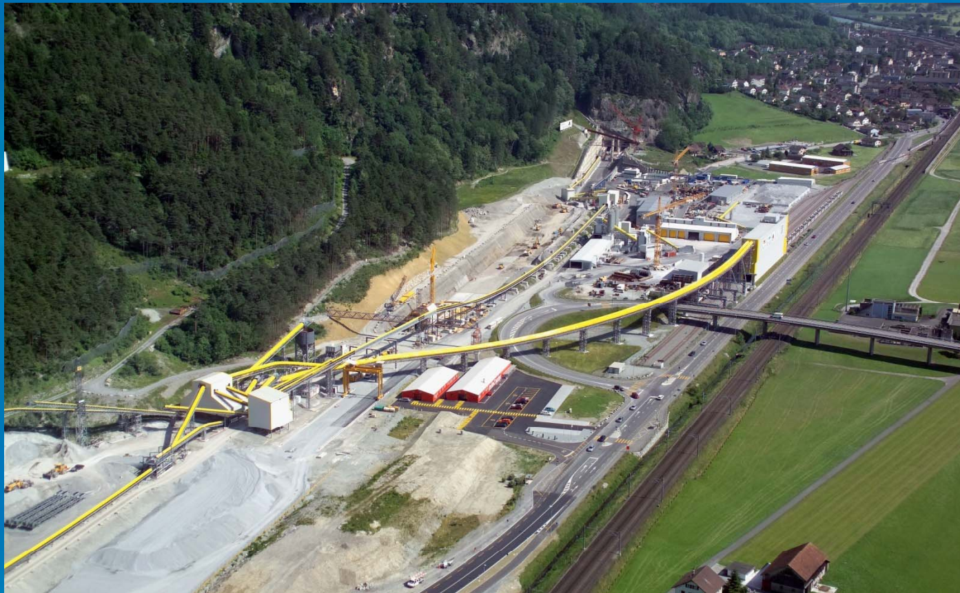
Gotthard-Basistunnel - Bauabschnitt Erstfeld, Nordportal
